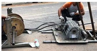
Rimozione di impianti in genere, condutture impianto elettrico
