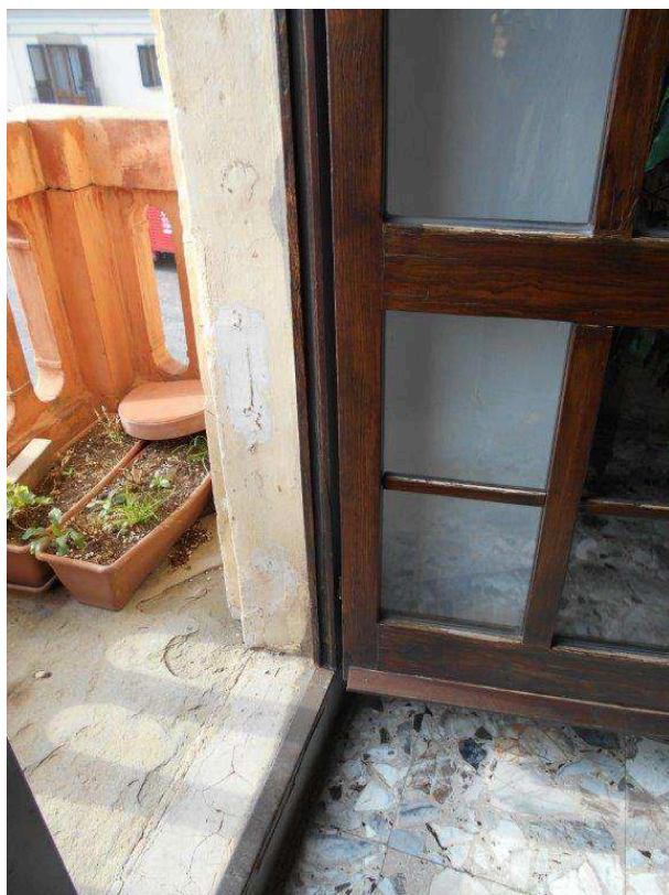
Figura 4 - particolare soglia non isolata
